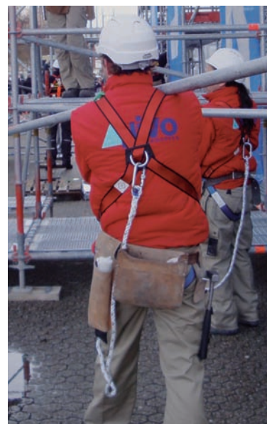
Figuur 1. Steigerbouwer (met dank aan Nivo Steigerwerken BV).
